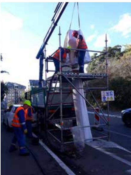
Увлачење флексибине континуалне цеви
