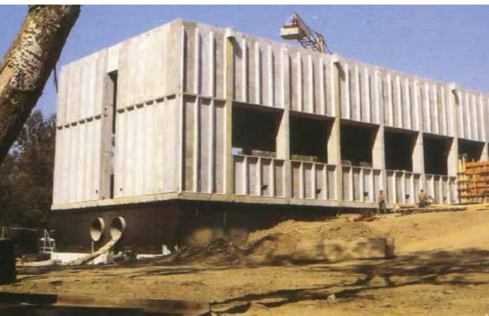
Црпна станица сирове воде на обали реке Саве, у изградњи
