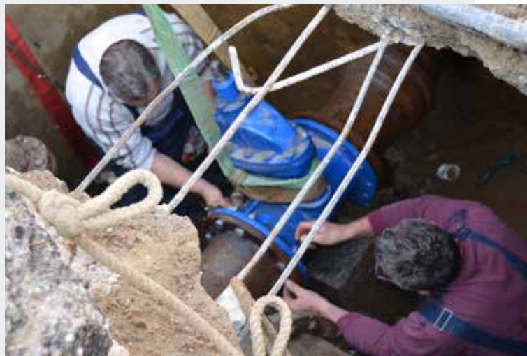
Монтажа новог затварача
