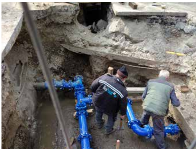
Реконструкција шахта на углу Будимске и Улице деспота Стефана
