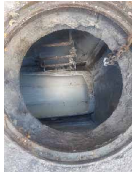
Пластична цев унутар колектора након примене рилајнинг методе
